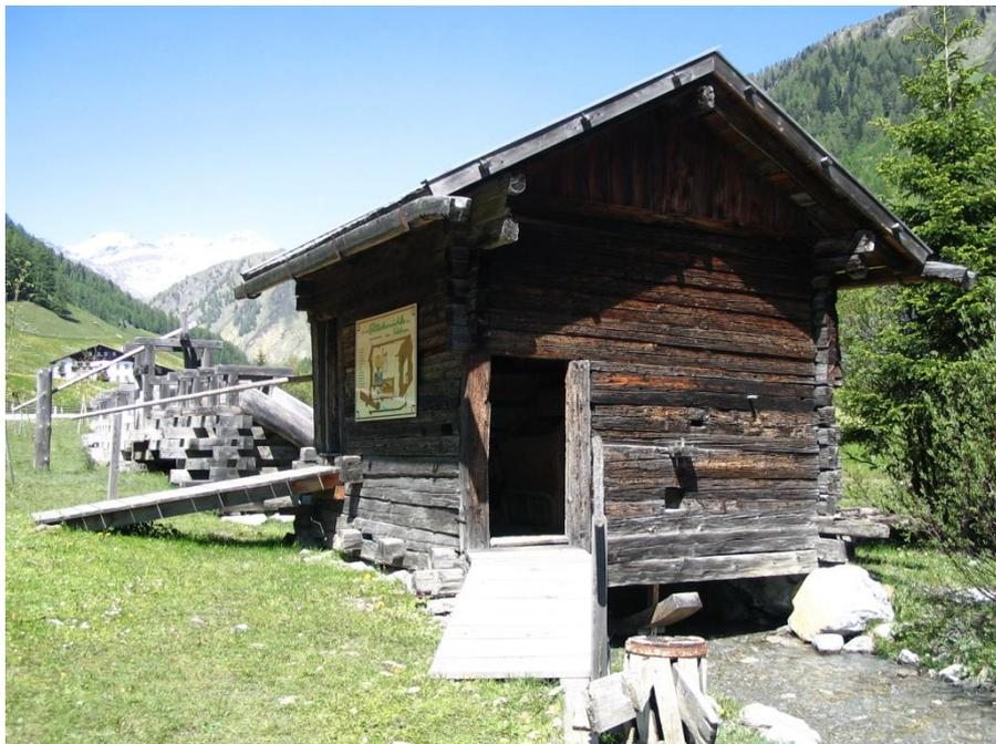
Das Besondere einer Stockmühle ist das auffällig konstruierte Wasserrad, das aber im Gegensatz zu den Radmühlen von außen am Mühlengebäude nicht sichtbar ist. In der technischen Beschreibung im behördlichen Wasserbuchakt zur „Oberen Schnattermühle“ wird als Antrieb für den Mahlgang „ein Holzrad mit vertikaler Achse“ angeführt. Das Wasser wird auf schräg gestellte Schaufeln dieses waagrechten Wasserrades mit senkrechter Welle geleitet.
