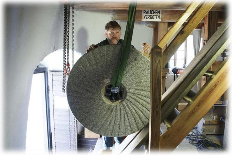
Aufziehen der in Holland gefertigten neuen Steine für den Mahlgang, der jetzt verwendet wird
