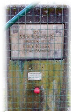
Haimzeichen Donaukraftwerk Abwinden-Asten beim Donaudükers
