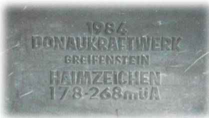
Wasserstandsmarke des Donaukraftwerkes Greifenstein
