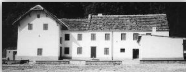
Die Kittingermühle (1984), in einem anmutigen Tal gelegen, gehörte zur Gemeinde Loibenreith. Sie ist die einzige der 10 entsiedelten Mühlen, die erhalten blieb.
