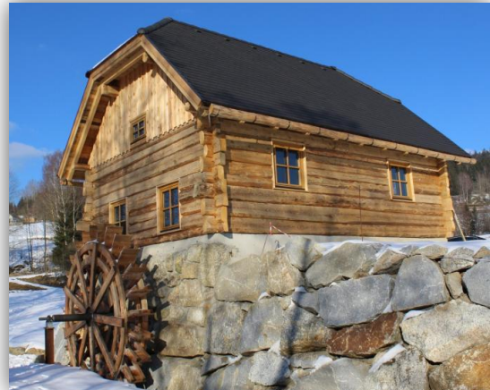
fertiges Mühlengebäude Feb. 2018 mit unterschlächtigem Wasserrad
