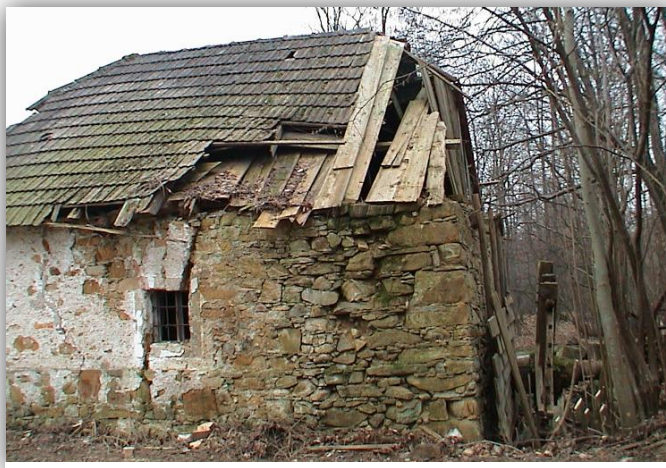
Pfaffenlehnermühle vor der Restaurierung 2002
