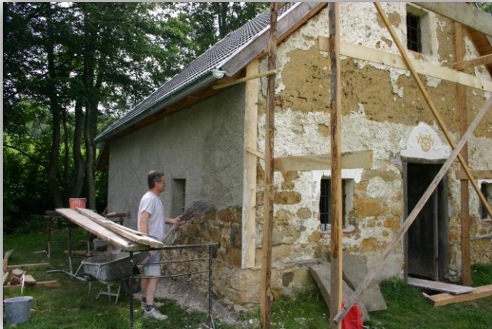
Wiederherstellung des Original-Außenputzes durch Abkehren mit dem Riedelbesen. 2006
