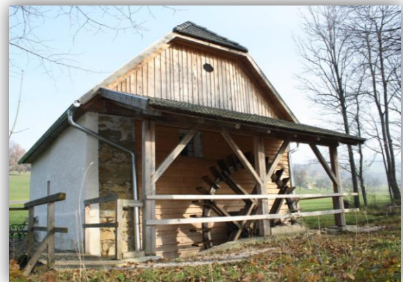
Unterschlächtiges Wasserrad, links ein Teil der Außenmauer unverputzt, um Einblick auf das ausgezwickelte Bruchsteinmauerwerk aus dem 16. Jhdt. zu bekommen. 2017
